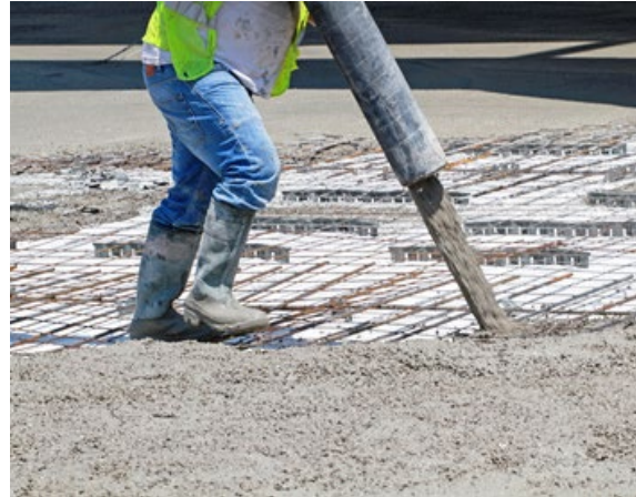
Abbildung 4.1: Ausbringung von Frischbeton. Quelle: www.immoexperten.de
